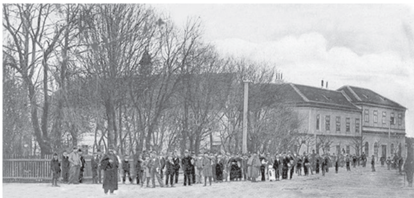
Római katolikus főgimnázium az Eötvös tér keleti sarkán (Schless Antal kiadása)
