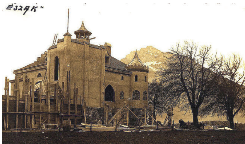
Az épülő „Villa Hungaria” északi oldala
