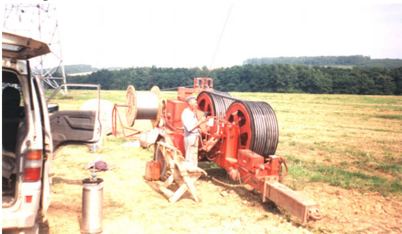
Fékező gép-egység védővezető terítésénél (1999)
