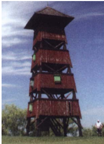
Nagykilátó. 14m-es, 4 emeletes, csonka gúla alakú. Anyaga: vörösfenyő hengeres fa, tölgyszelvényáru, faszindely héjalás
