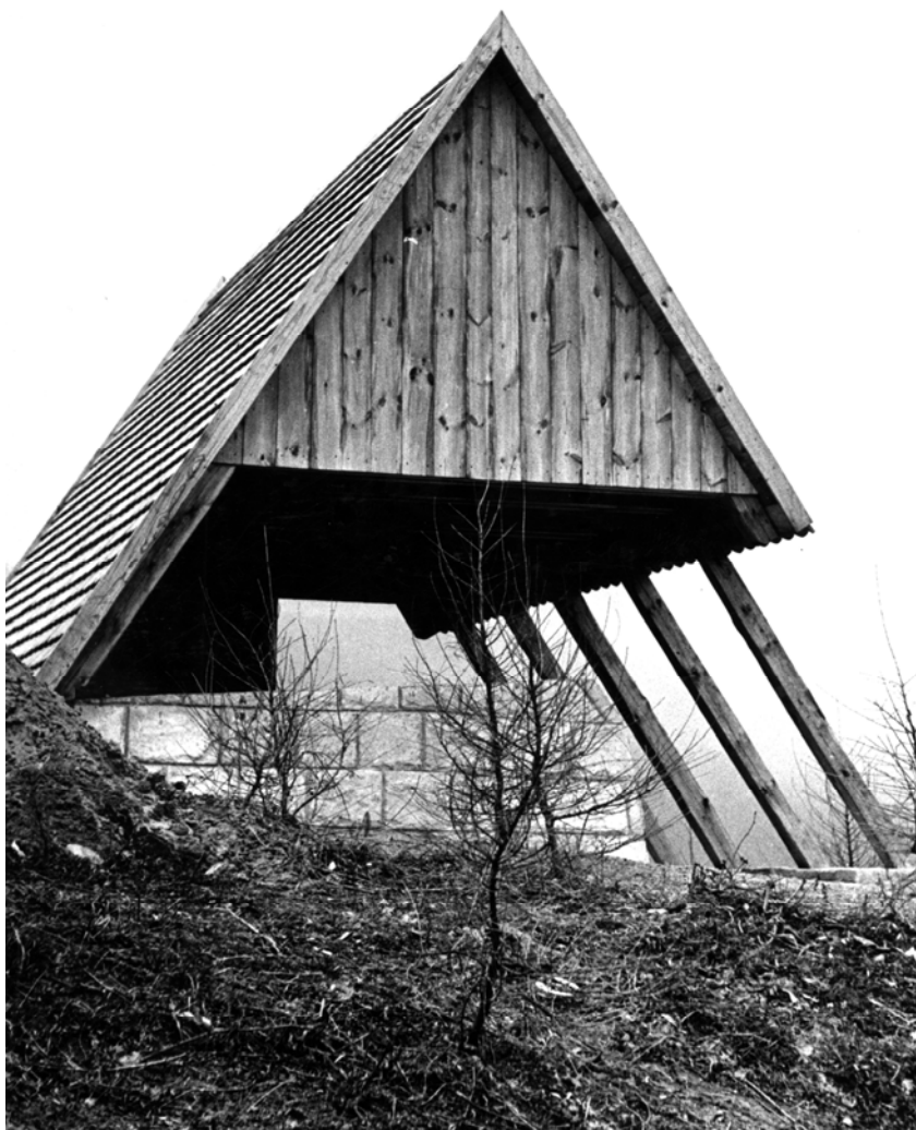
Alpesi tetős, fazsindely héjalású esőbeállólóház. Három oldal faragott kőfalazattal zárt, a negyedik oldal nyitott, a nyújtott, hosszú szarufák betonpillérekbe beépítve
