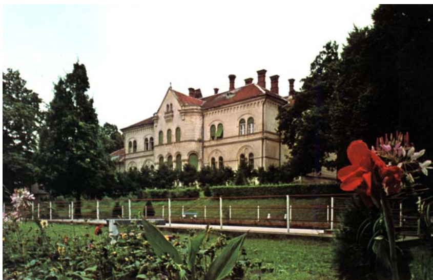
Ormándpusztai SZOT gyermeküdülő képei. Az eklektikus stílusú épület korábban Somssich gróf tulajdona volt a parkkal és a környező erdőkkel
