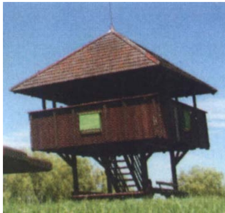
Kiskilátó. 7,7m-es, 1 emeletes, egyenes tartóoszlopokkal, kiugró erkéllyel. Anyaga: minden szelvényezett vörösfenyő, erdeifenyő, tölgyfa, faszindely héjalással
