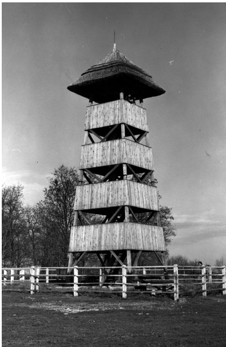
A bivalyrezervátum 13,5 m magas kilátója. A kilátó csonkagúla alakú, 4 emeletes, anyaga vörösfenyő és tölgy szelvényárú, védőkerítéssel ellátva. Fedése sátoztető, nádfedéssel
