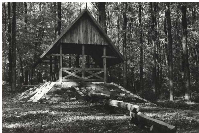
Kútház. fűrészelt, oszlopokon álló épület. „Medve” típusú szivattyúval működik, ásott kútból, csővezetékéről, csurgalék víz elvezetése rönkbe vást csatornán
