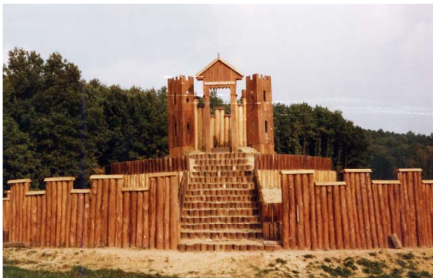
A Kanizsa-vár építésének első ütemében elkészültek a palánkmezők, a fellegvár és az odavezető fából készített lépcsősor
