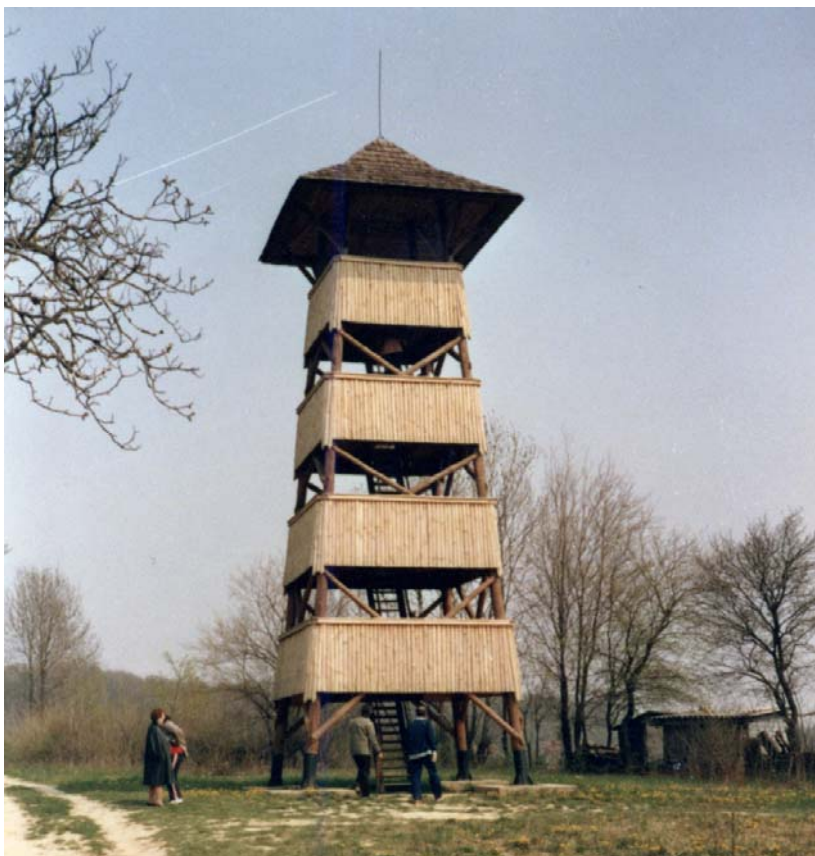
Parkerdő kilátó. Építés 1980. 14m magas, 4 emeletes. Anyaga: vörösfenyő hengeres fa, erdeifenyő félhengeres fa. Héjalás: fazsindely. Lebontva: 2005-ben, 25 év után
